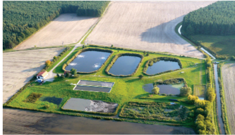
Hier sollen bald Pappeln wachsen: Flächen der Energieholzplantage bei der Teichkläranlage der Stadt Uebigau-Wahrenbrück. Foto: Erwin Noack
